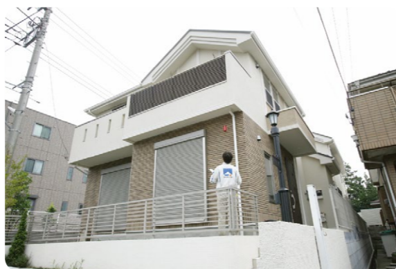
竣工時に、主に、内装の仕上げや仕上りの寸法の状況、住宅部品や設備機器の設置状況などを確認します。
