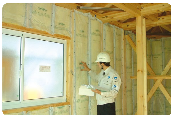
内装下地張り直前の段階に、主に竣工時に隠蔽される外壁等の構造、各部の断熱構造など確認します。
