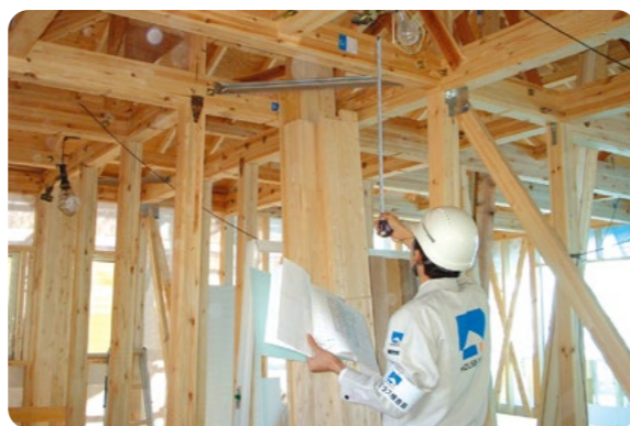
躯体工事の完了時に、主に建物骨組の構成、構造部材の規格、部材の接合部の状態、耐久性向上のための対策などを確認します。
