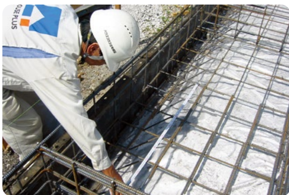
基礎の配筋工事の完了時に、基礎配筋の施工状況等を確認します。
