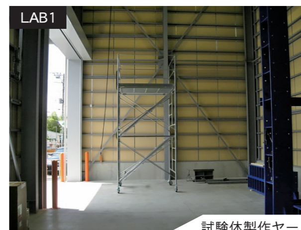
LAB1 試験体製作ヤード
